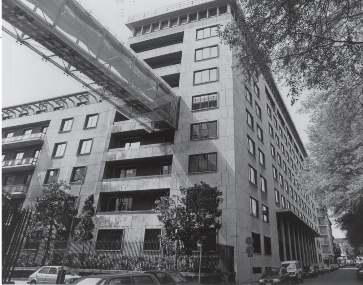
■ La sede degli uffici Fiat di Corso Marconi a Torino
